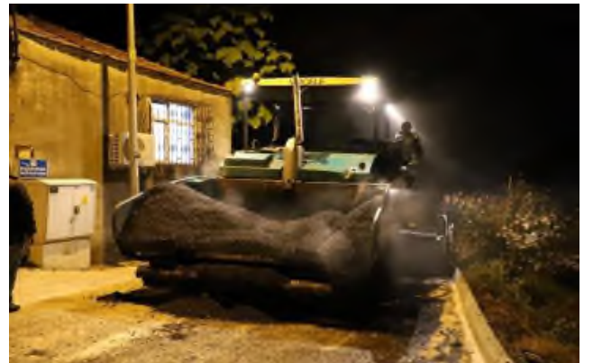
Bahçelievler nadir pulat sokak asfalt çalışması
