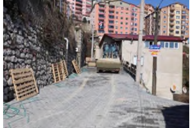
Mithatpaşa mahallesi dağyolu sokak parke çalışması
