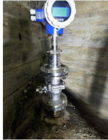
Tip Elektromanyetik Debimetre
