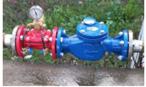
Basınç Düşürücü Vana, Pislik Tutucu Vana ve Vantuz Tesisatı
