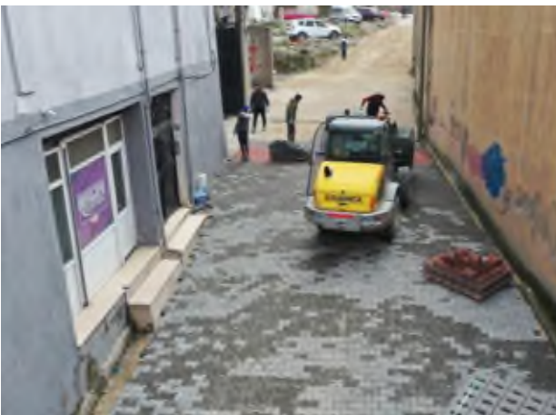
Ontemmuz mahallesi reşit paşa sok parke çalışması
