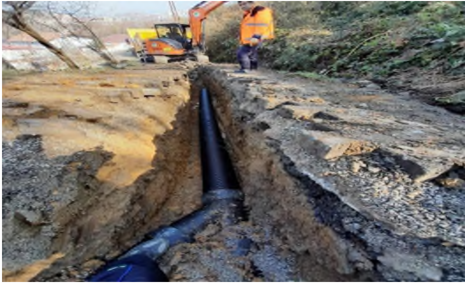
Ontemmuz Mahallesi Ziya Kalyoncu Sokak Kanalizasyon Hattı Yapım İşi
