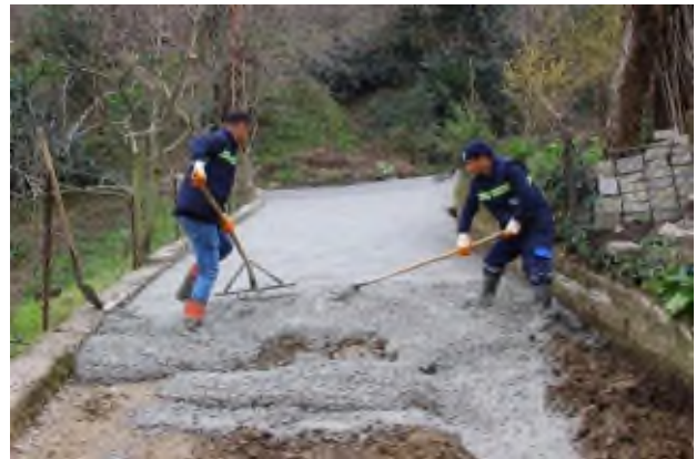
Birlik mahallesi şifa sok beton yol çalışması
