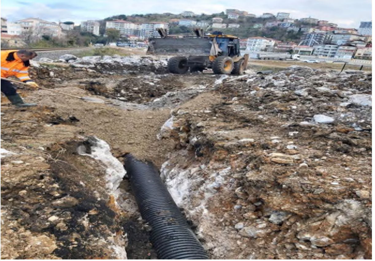
Yeşil Mahalle Uzunkum Caddesi Kanalizasyon Hattı Yapım İşi
