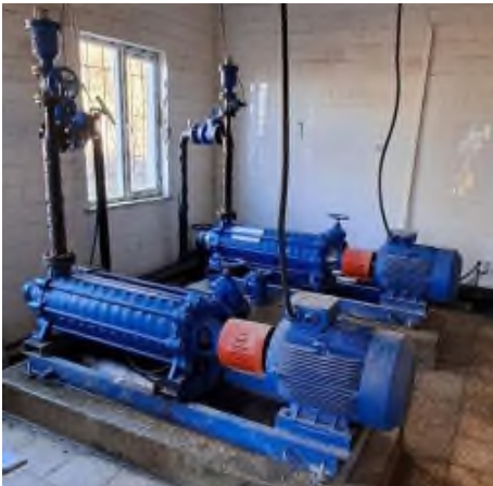
Kıransoy Terfi Merkezi İçme Suyu Pompaları ve Elektrik Panoları
