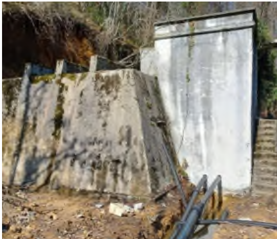
Baraj yolu üstü İçme Suyu Deposu
