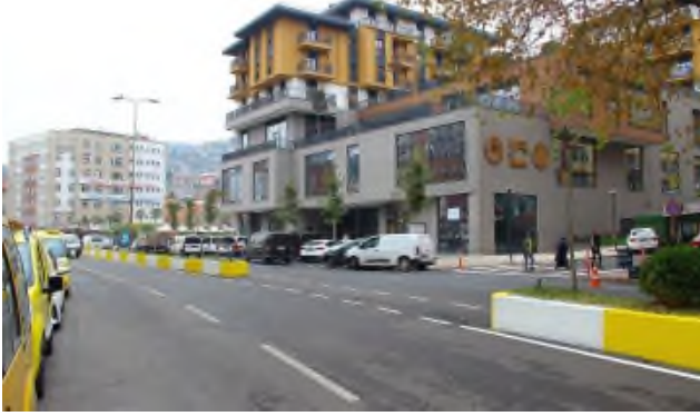
Acılık caddesi. asfalt ve çevre düzenlemesi
