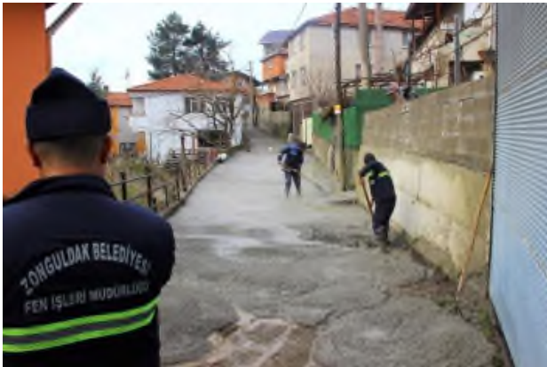
Baştarla mahallesi mehmet maksut sokak beton yol çalışması
