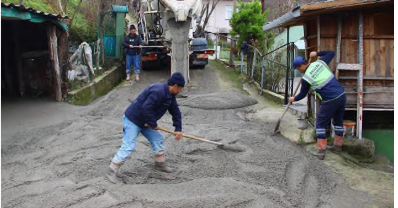
Çınartepe mahallesi turna sokak beton yol çalışması
