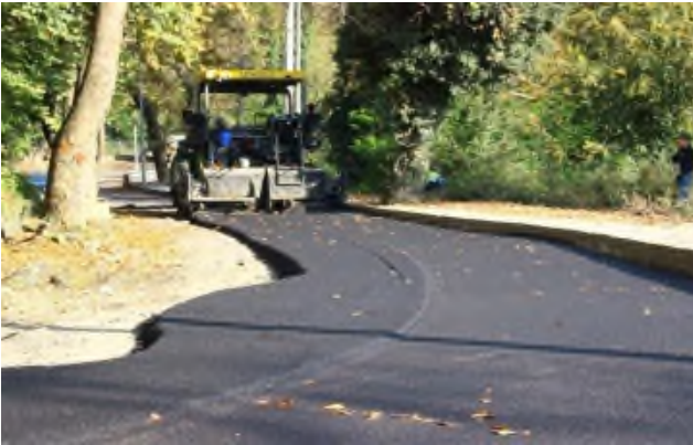
Asma-Yenişehir Sokak'ta asfalt çalışması
