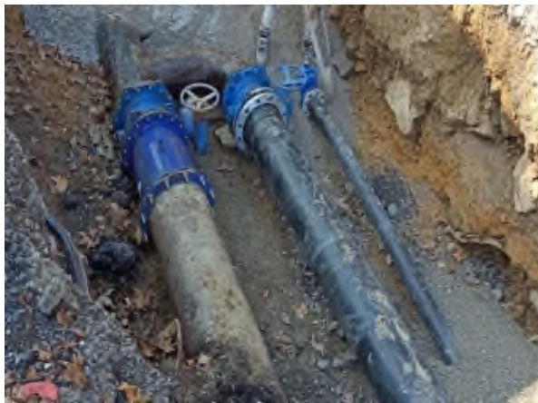
YERİNE DÖŞEDİĞİMİZ POLİETİLEN İÇMESUYU BORULARI
