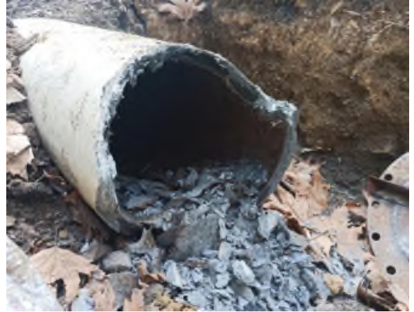
İPTAL ETTİĞİMİZ ESKİ ASBEST BORULAR
