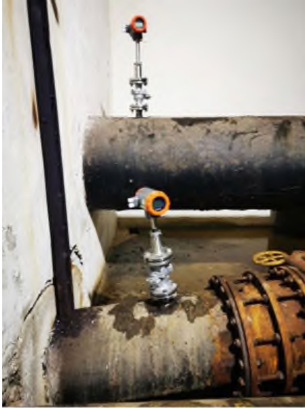
Tip Elektromanyetik Debimetre
