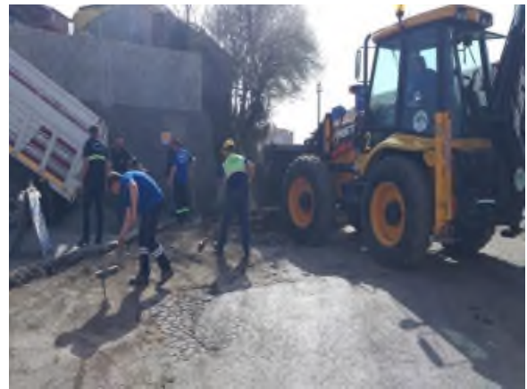
TEPEBAŞI MAHALLESİ DEĞİRMENBAŞI SOKAK İÇME SUYU HATTINDAKİ ARIZANIN GİDERİLMESİ İÇİN YAPILAN ÇALIŞMAMIZ
