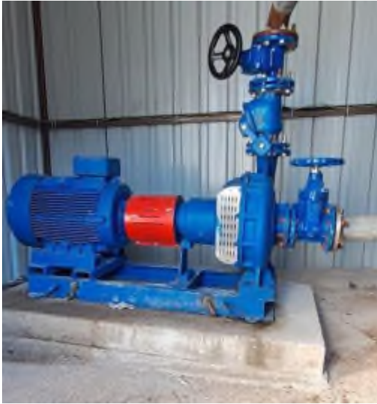
Yeni İçme Suyu Pompası ve Panosu
