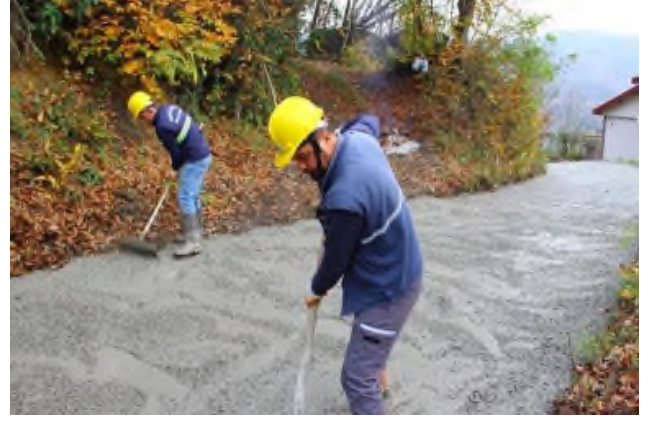
Dilaver Pilot Yusuf Dal Sokak beton yol çalışması
