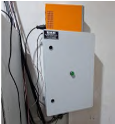
PLC ve Pompa Elektrik Panoları
