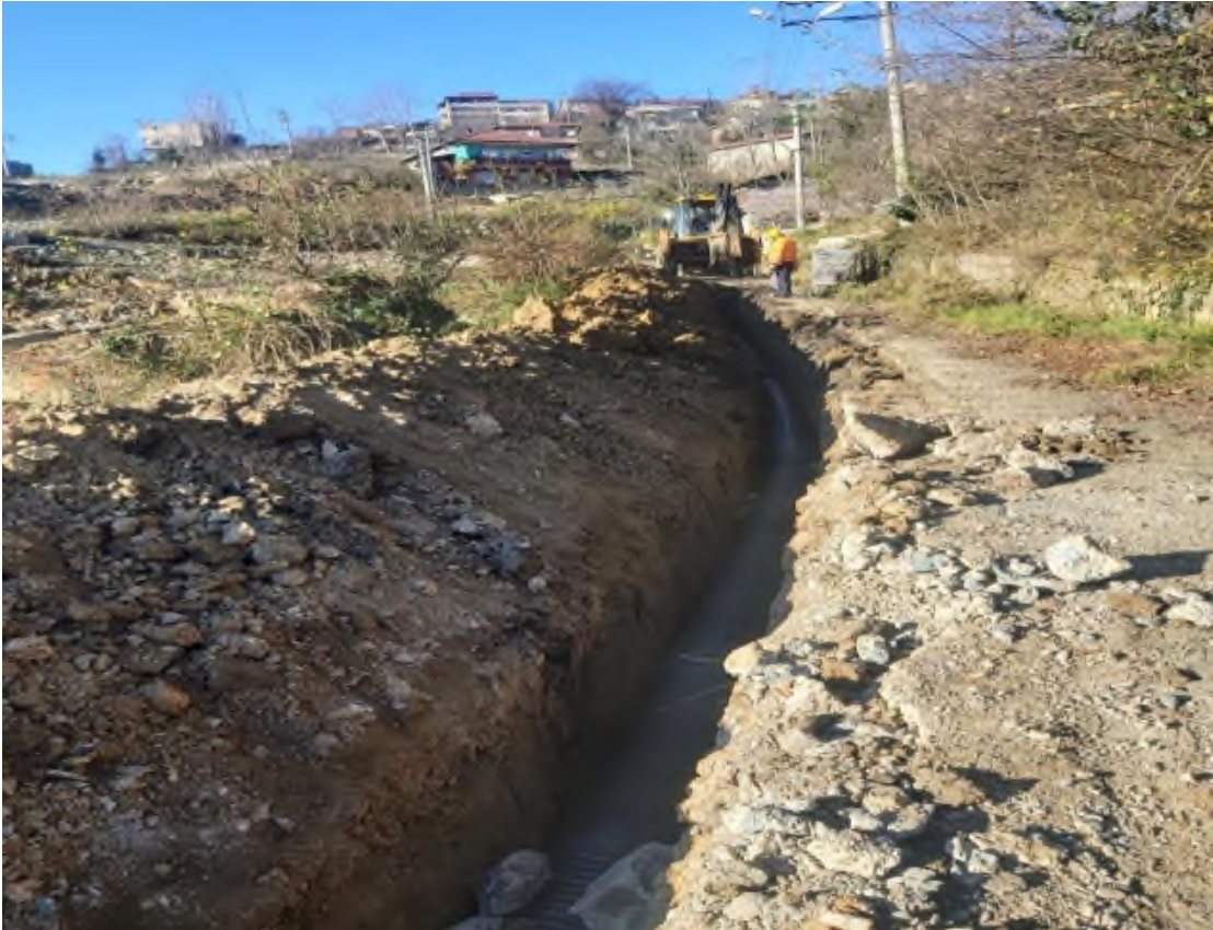
Rat Mahallesi Toki 2. Etap Kanalizasyon Hattı Yapım İşi
