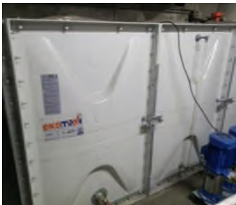
Yeni Depo ve Hidrofor Sistemi
