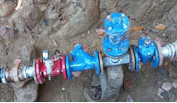
Basınç Düşürücü Vana, Pislik Tutucu Vana ve Vantuz Tesisatı
