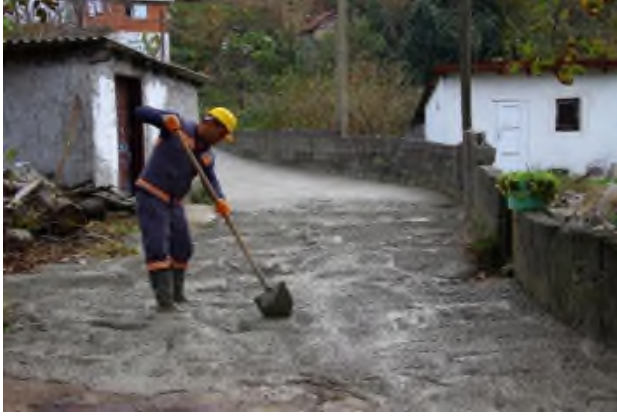
İnağzı Mahallesi Dilektepe Sokak beton yol çalışması
