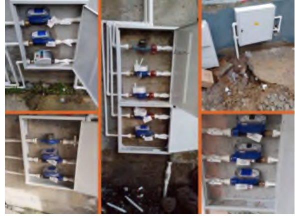
ASMA- DİLAVER MAHALLELERİNDEKİ YENİ İÇME SUYU HATLARININ SAYAÇ BAĞLANTILARININ YAPILMASI VE SAYAÇ PANOLARININ MONTAJI
