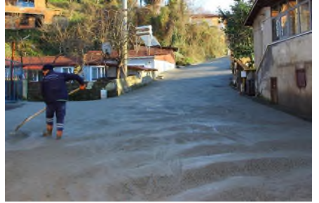
Kemberbaca beton yol çalışması
