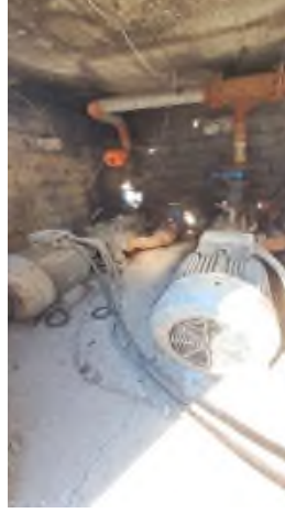
İptal Edilen Alt Kemerbaca Terfi 90 Kw İçme Suyu Pompaları
