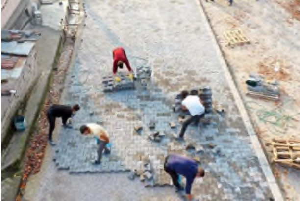
Dilaver Mahallesi Sınır Sokak parke çalışması
