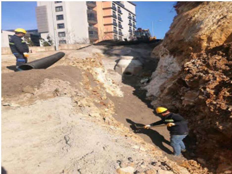
Tepebaşı Mahallesi Stad Üstü 88 Evler Sokak Kanalizasyon Hattı Yapım İşi
