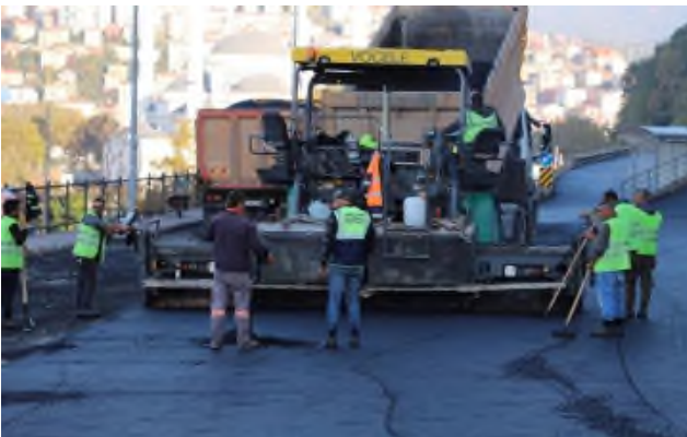
Bahçelievler-Balkaya cd asfalt çalışması
