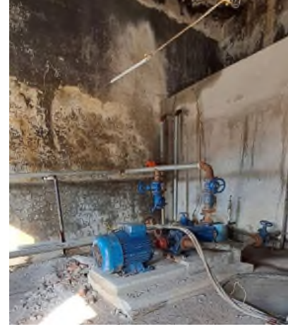
İptal edilen Dilaver Terfi Merkezi
