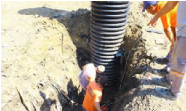
Ontemmuz zakkum sk. menfez ve yağmur suyu hattı yapımı
