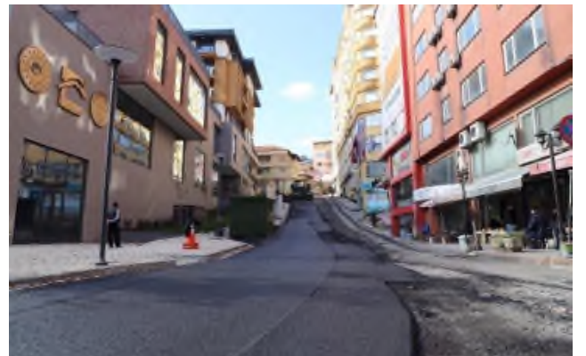
Acılık caddesi elmas park mevki asfalt çalışması
