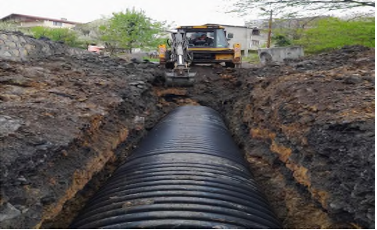
Tepebaşı Mahallesi Taşocağı Sokak Kanalizasyon Hattı Yapım İşi (Kuran Kursu)
