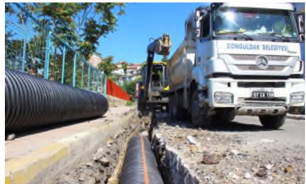
Atatürk devlet hastanesi önü-yağmur suyu hattı çalışması
