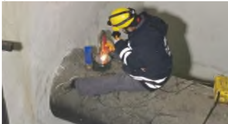
İsale hattı üzerine daldırma tip debimetre montajı
