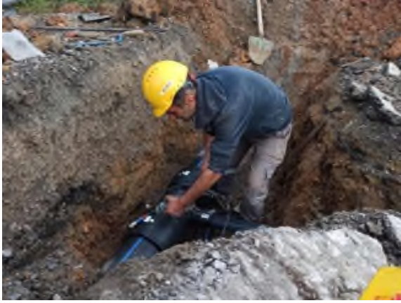
ÇAYDAMAR MAHALLESİ KOKAKSU MEVKİ İÇMESUYU HATTI YENİLEME
