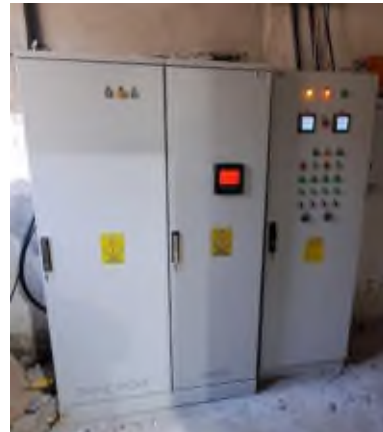
PLC ve Pompa Elektrik Panoları
