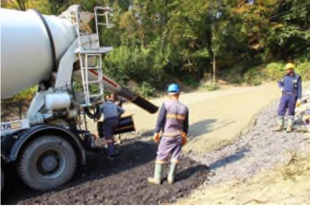
Dilaver Mahallesi Elma Sokak beton çalışması
