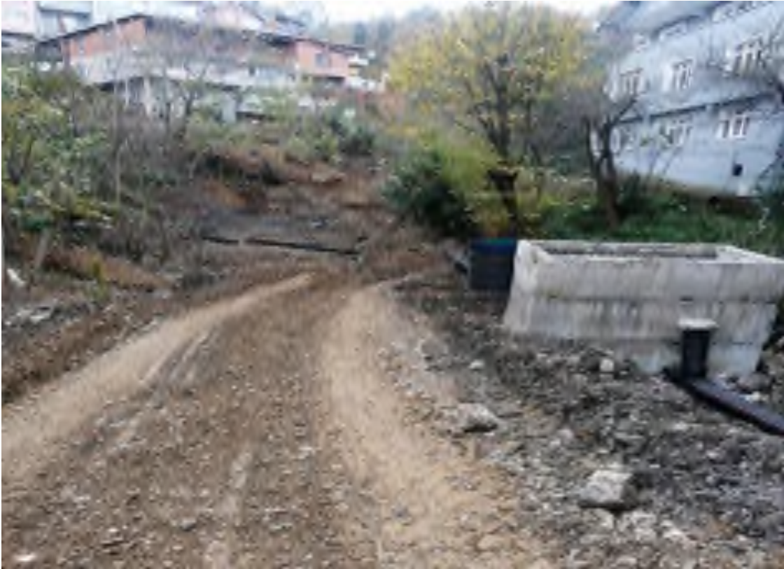
Tepebaşı Mahallesi Ömer Seyfettin Sokak Kanalizasyon Hattı Yapım İşi
