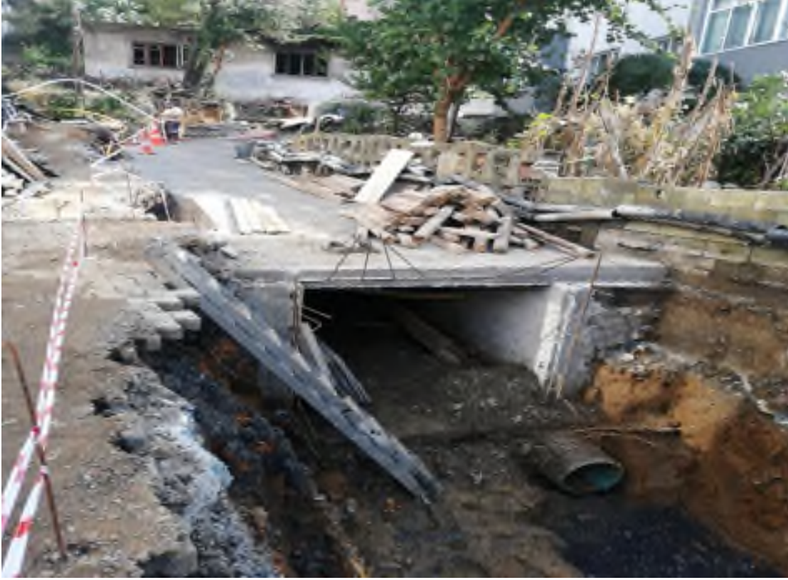
Bahçelievler Mahallesi Açelya Sokak Kanalizasyon Hattı Yapımı
