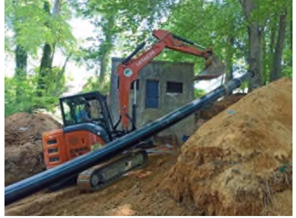
KEMERBACA SU DEPOSU BAĞLANTISI
