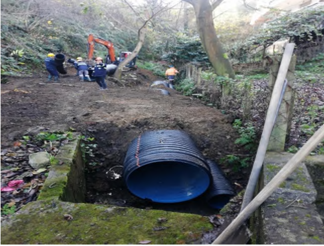
Terakki Mahallesi Kır Sokak Kanalizasyon Hattı Yapım İşi
