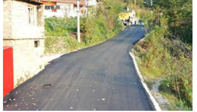
Asma mahallesi sınır sok asfalt çalışması
